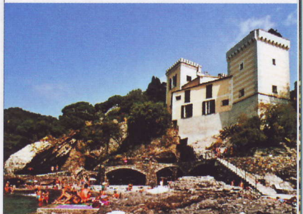
Castello di Canevaro, costruito a picco sul mare di Zoagli
